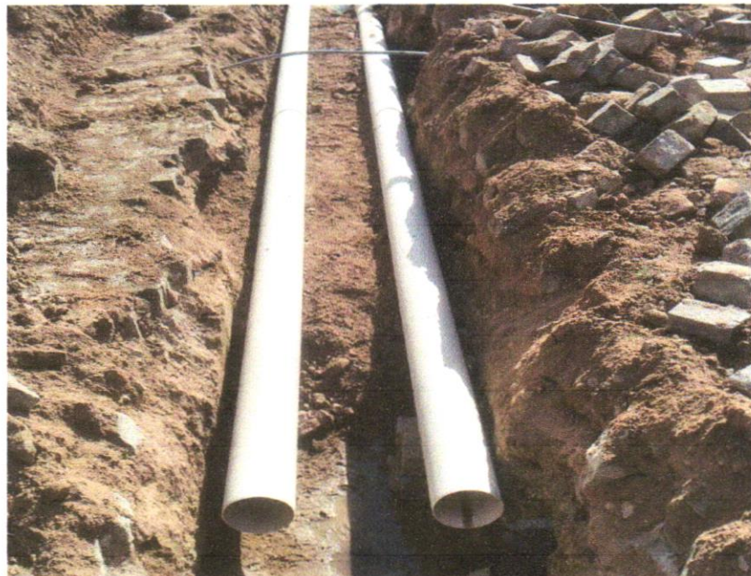
FOTO 04 - ESCAVAÇÃO MANUAL DE VALA COM PROFUNDIDADE MENOR OU IGUAL A 1,30 M
